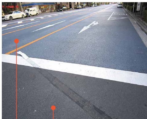
遮熱性舗装 一般のアスファルト舗装
