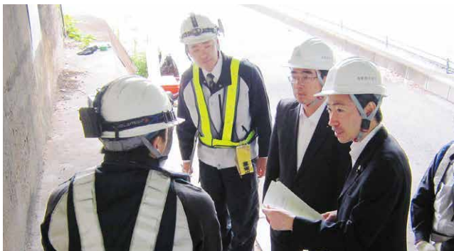
築地橋の健全度調査を視察(平成26年5月)
